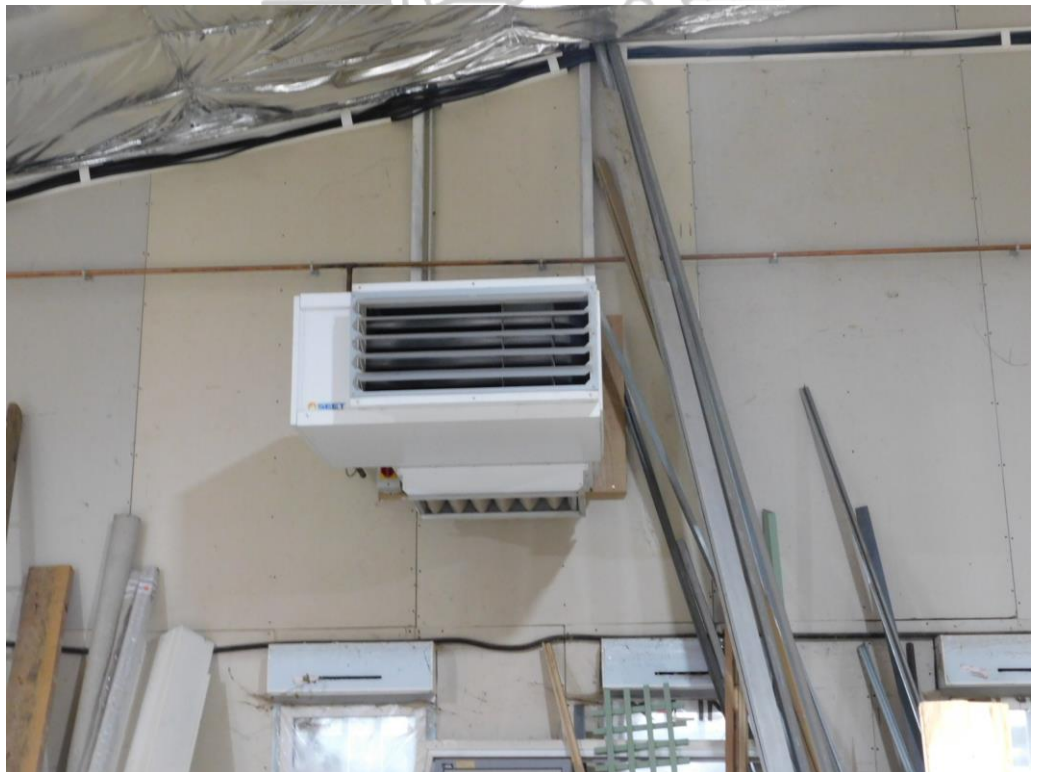
Chauffage : deux aérothermes fonctionne au gaz
