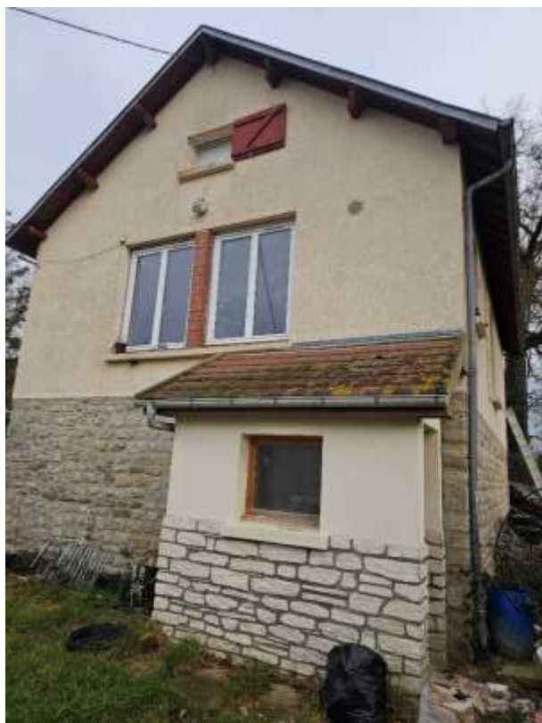
Façade arrière (côté moulin) :
