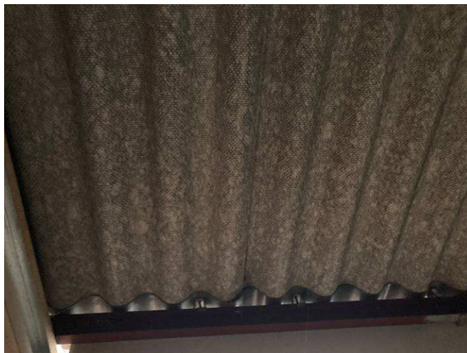
Toiture / Plafond : Plaques ondulées en amiante-ciment
