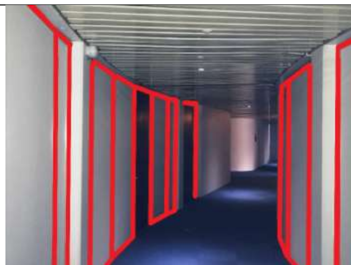
Joints cloisons entre les éléments de cloisons de séparations, parties privatives et parties communes
