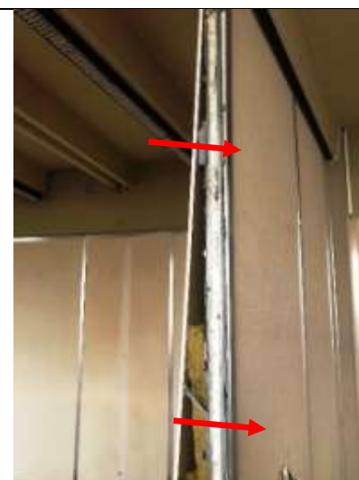
Détails des Joints cloisons sur élément de cloison ouvert
