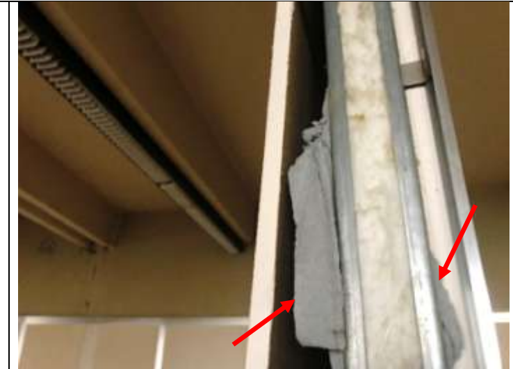
Détails des Joint cloisons sur élément de cloison ouvert
