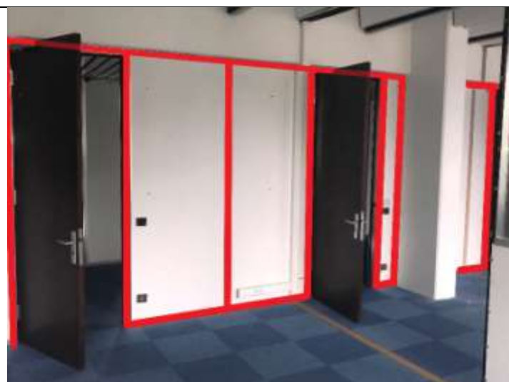
Joints cloisons entre les éléments de cloisons de séparations, parties privatives et parties communes
