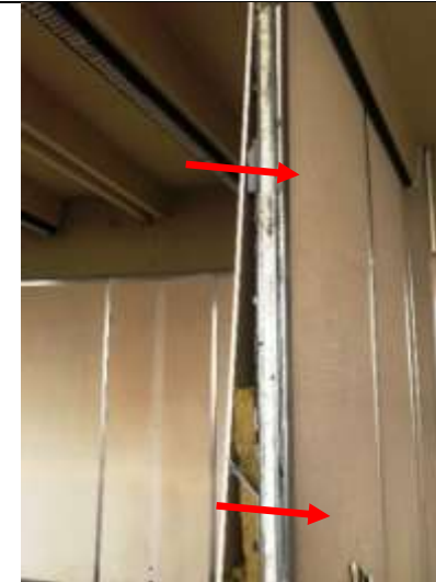
Détails des Joint cloisons sur élément de cloison ouvert
