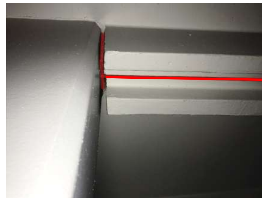
Joint de dilatation entre éléments de plancher béton et pilier.
