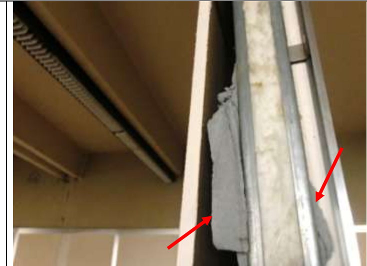
Détails des Joint cloisons sur élément de cloison ouvert
