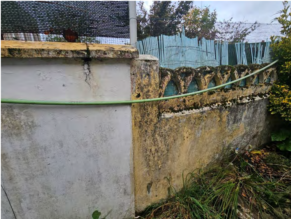
Clôture avec le voisin en béton.
