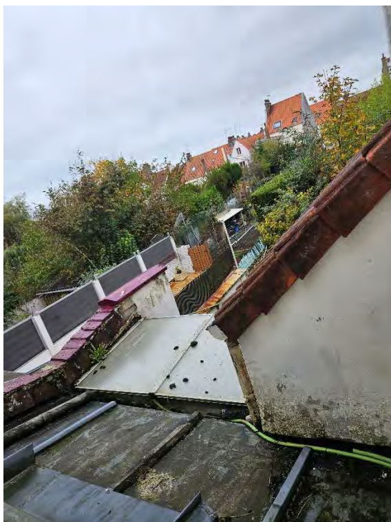
Vue sur toit de la cuisine en Zinc
