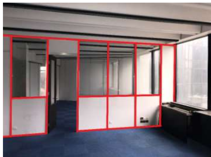
Joints cloisons entre les éléments de cloisons de séparation des parties privatives.
