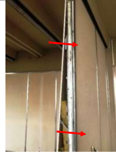
Détails des Joint cloisons sur élément de cloison ouvert
