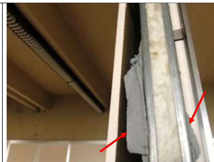
Détails des Joints cloisons sur élément de cloison ouvert
