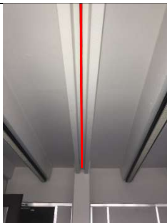
Joint de dilatation entre éléments de plancher béton.
