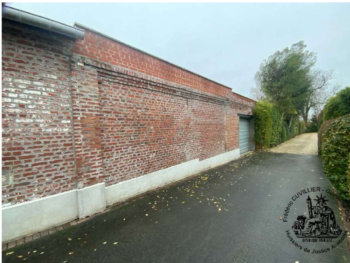
Vue du bâtiment parcelle n°139 depuis l'accès macadam arrière :
