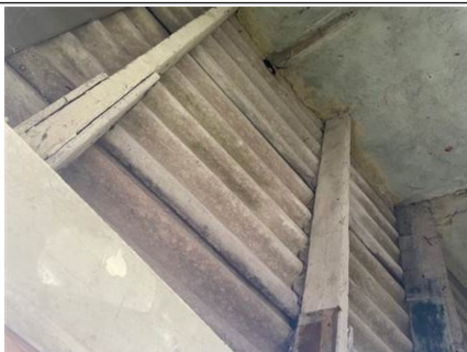
Photo n° PhA005 Localisation : Rez de chaussée - DEPENDANCE Ouvrage : 1 - Couvertures, Toitures, Terrasses et étanchéités - Plaques ondulées et planes Partie d'ouvrage : Plaques en fibres-ciment (y compris plaques « sous tuiles ») Description : Plaques en fibres-ciment (y compris plaques « sous tuiles »)
