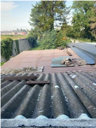
Photo n° PhA002 Localisation : Rez de chaussée - CUISINE Ouvrage : 1 - Couvertures, Toitures, Terrasses et étanchéités - Plaques ondulées et planes Partie d'ouvrage : Plaques en fibres-ciment (y compris plaques « sous tuiles ») Description : Plaques en fibres-ciment (y compris plaques « sous tuiles »)
