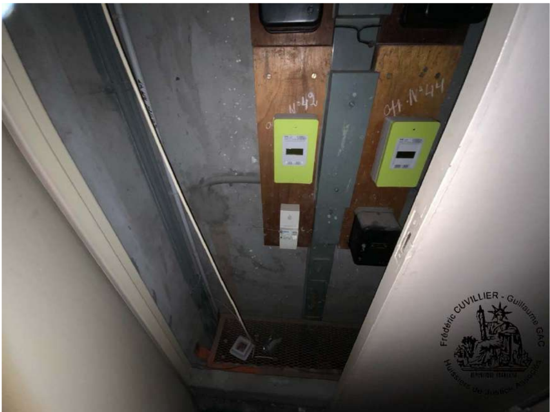
Compteurs type Linky au niveau des parties communes :
