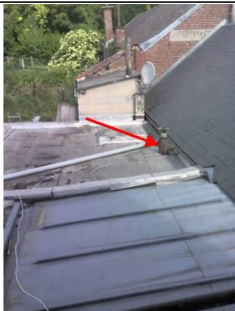
Photo n° PhA002 Localisation : Parties extérieures Ouvrage : Mitron et conduit Partie d'ouvrage : Mitron et conduit Description : Mitron et conduit Localisation sur croquis : M002
