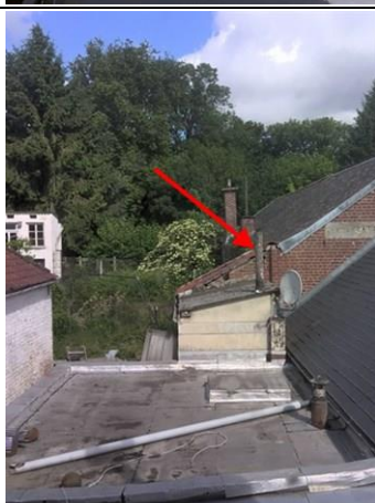
Photo n° PhA004 Localisation : Jardin - Abris 1 Ouvrage : 6 - Conduits et accessoires intérieurs - Conduits de fluides (air, eau, vapeur, fumée, échappement, autres fluides) Partie d'ouvrage : Conduit en fibres-ciment Description : Conduit en fibres-ciment Localisation sur croquis : M004
