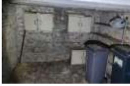
Pathologie observée - Présence d'humidité sur plusieurs parois du sous-sol. Cette humidité peut dégrader la qualité de l'air intérieur et favoriser le développement de moisissures et de champignons, entraînant des risques pour la santé des occupants.
