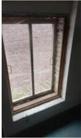
Défaut d'étanchéité au niveau de la menuiserie, infiltration d'eau et d'air. Cette humidité peut favoriser l'apparition de moisissures et de champignons, compromettant non seulement la qualité de l'air intérieur, mais également la durabilité des matériaux de construction. Si ces infiltrations ne sont pas traitées rapidement, elles peuvent entraîner des pathologies plus graves.
