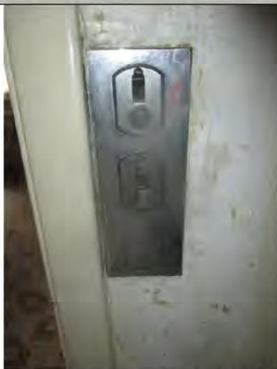
**Description :** Le type d'au moins un FUSIBLE ou un DISJONCTEUR n'est plus autorisé (fusible à tabatière, à broches rechargeables, COUPE-CIRCUIT A FUSIBLE de type industriel, DISJONCTEUR réglable en courant protégeant des CIRCUITS terminaux).
