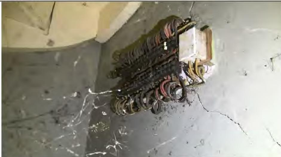
**Description :** L'installation comporte au moins un CONDUCTEUR ACTIF dont le diamètre est  $< 12/10 \text{ mm}$  ( $1,13 \text{ mm}^2$ ).
