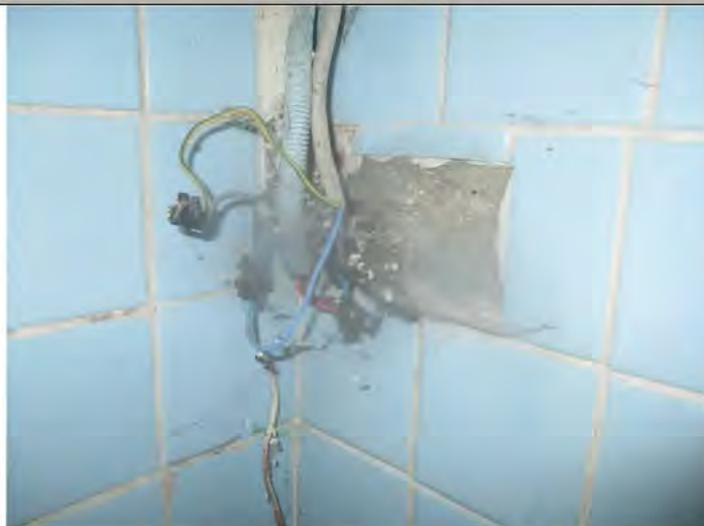
**Description :** L'installation électrique comporte au moins une CONNEXION avec une partie active nue sous tension accessible.
