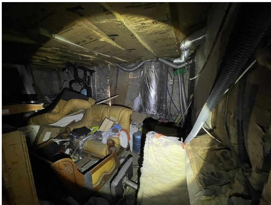
Photo n°19 : vue du grenier.
