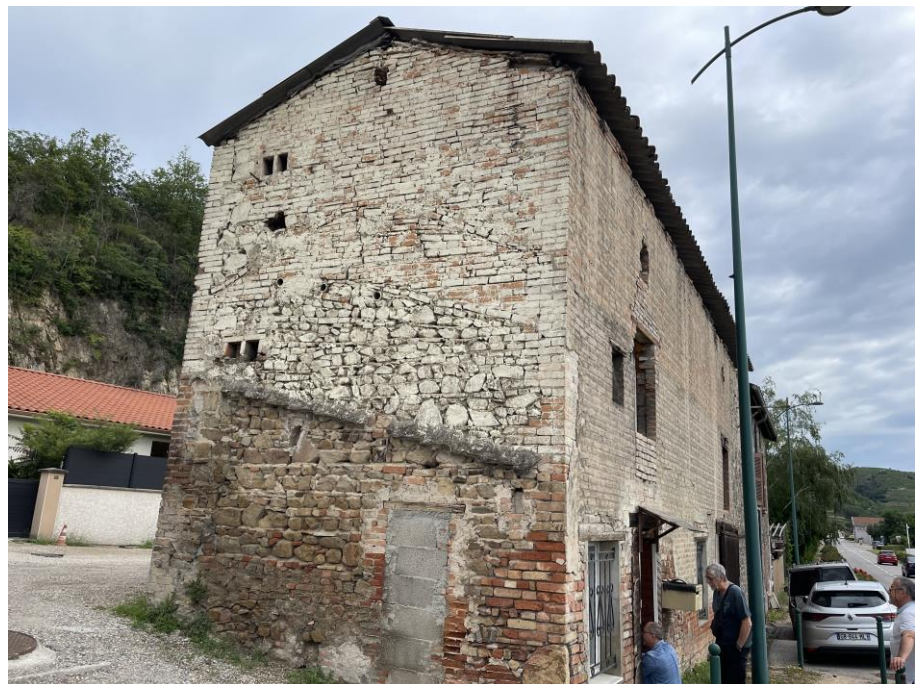
Photo n°4 : vue de la façade Sud.
