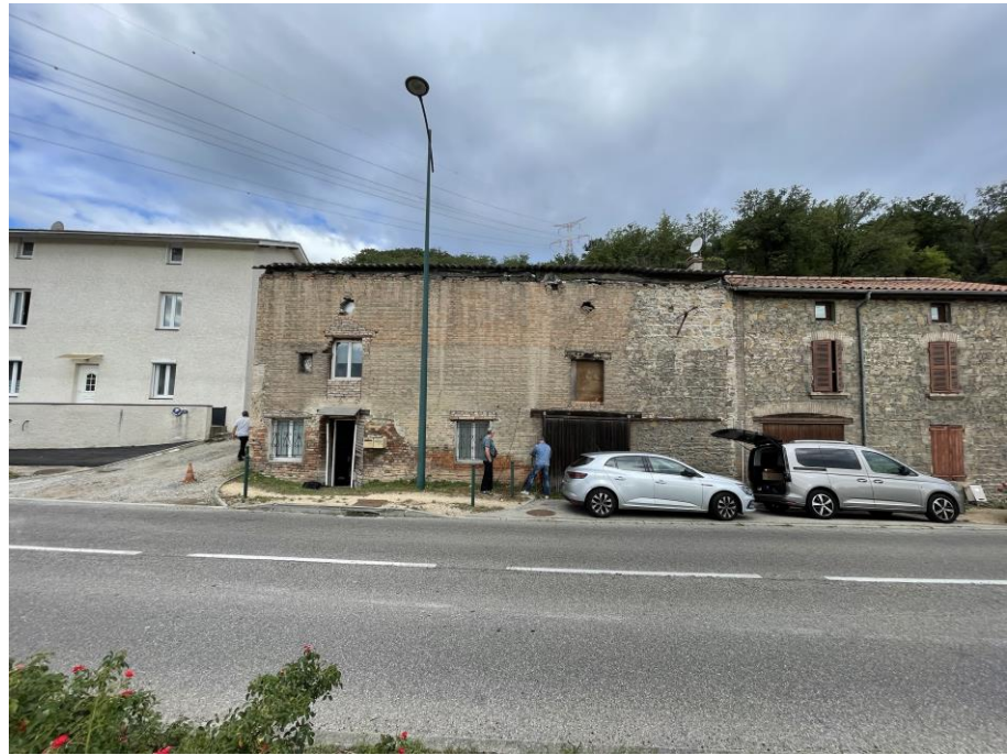
Photo n°3 : vue de la façade sur la Route Nationale 86.
