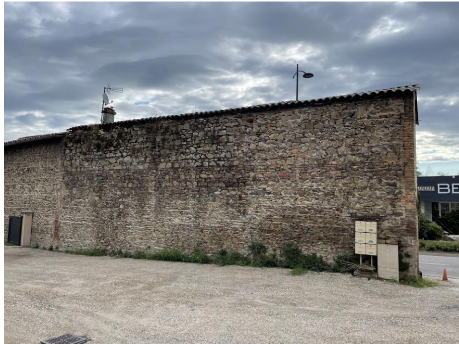
Photo n°5 : vue de la façade Ouest.
