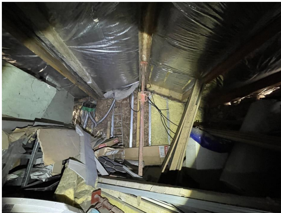
Photo n°22 : vue du grenier niveau N+2.
