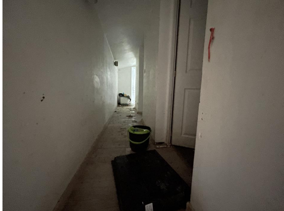
Photo n°27 : vues de la du dégagement.
