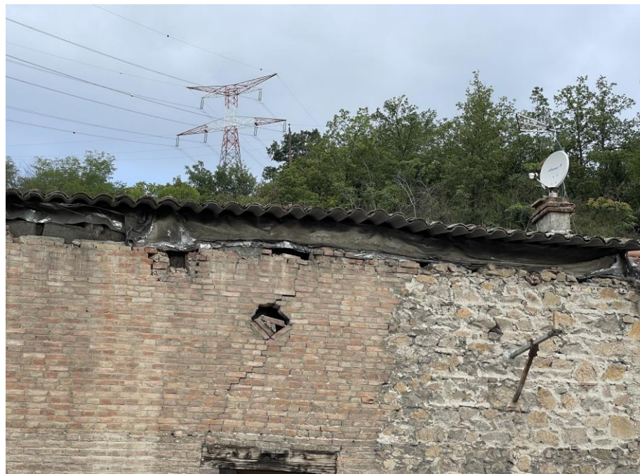
Photo n°6 : vue du déport de toit Est.
