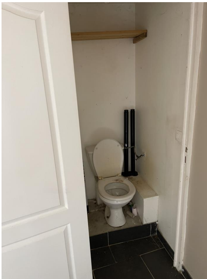
Photo n°13 : vue du cabinet d'aisances.
