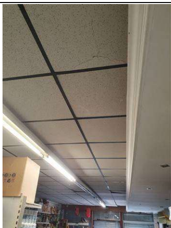
Photo n° PhA001 Localisation : Rez de chaussée - Local commercial Ouvrage : 1. Flocages, Calorifugeages, Faux plafonds Partie d'ouvrage : Faux plafonds Description : Faux plafonds
